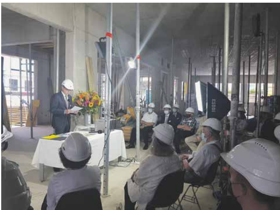
GRUNDSTEINLEGUNG AUF DER BAUSTELLE DES GENERATIONENHAUSES.
