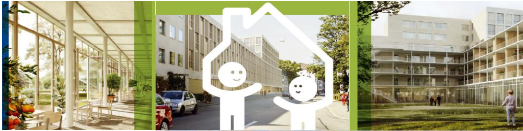
Neubau Generationenhaus Neubad - Copyright bei Ackermann Architekt BSA SIA AG
